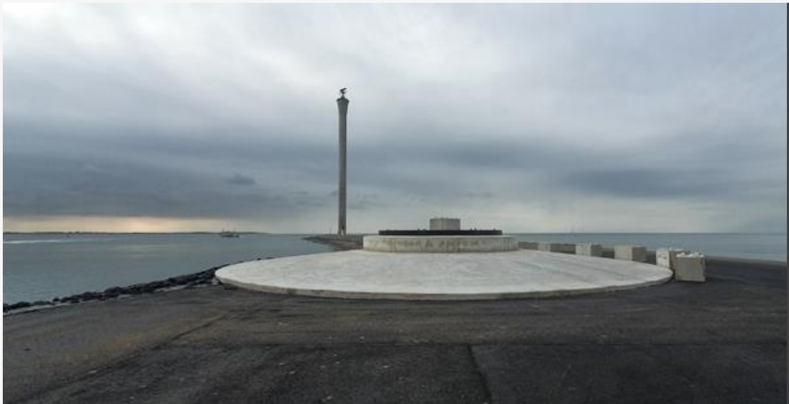
Een gerealiseerde fundatie eind 2020.
