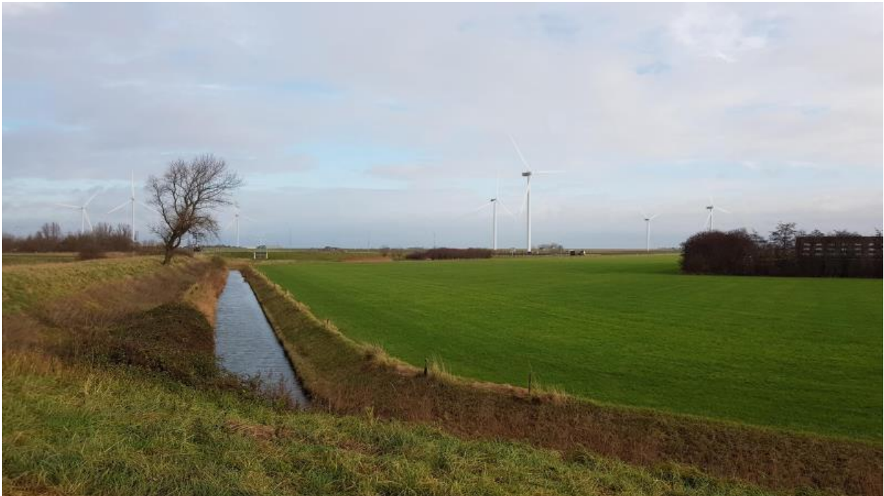
Locatie 1 Visualisatie na vervanging windpark Noord-Beveland én Windpark Jacobahaven (tiphoogte 150 meter)
